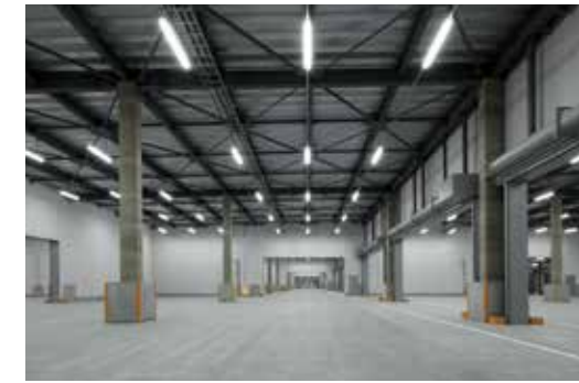
倉庫部分はRCS構法を採用。圧縮に強いRC造と軽量で曲げやせん断に強いS造を組み合わせることで、柱間隔11m（柱芯）、梁下有効高5.5mという大きな空間を確保した
