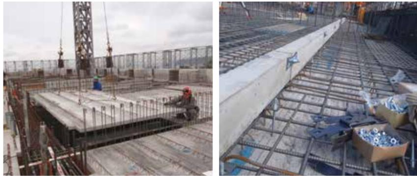
PCa化したALCパネルの立ち上がり部。このKHスラブと立ち上がり部は、敷地内に確保したスペースでPCa部材として製作した。敷地内にその製作スペースを持つことで、製作工場から公道上を運搬するときに課される制約にとらわれることなく、部材の大きさや形を決めることができる
