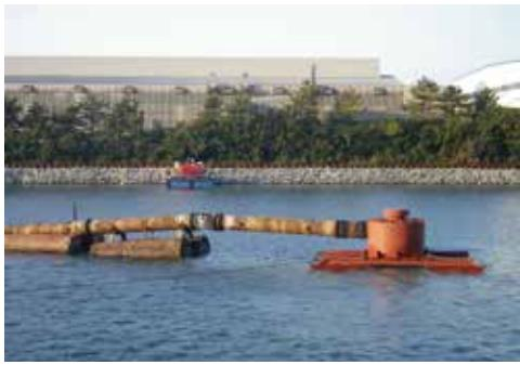
西地区は東地区より広範囲に及ぶため、東地区で用いた定置式の減勢サイクロンでは対応できない。そこで、写真のようなサイクロン台船を製造し、同時に製造したワインチ台船と護岸に設置した滑車を用いて移動させながら、カルシア改質土を打設した
