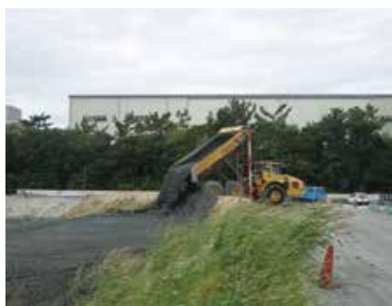
カルシア改質土の打設には重ダンプも利用。ベルトコンベア下の貯泥槽に溜まった改質土を積み込み、打設地点まで運搬し、流し入れていった。そこでもダンプアップによる落差2mの落下が生じるため、混合効果はさらに高まることになる
