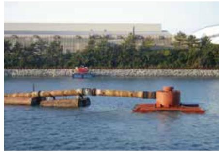
西地区は東地区より広範囲に及ぶため、東地区で用いた定置式の減勢サイクロンでは対応できない。そこで、写真のようなサイクロン台船を製造し、同時に製造したウインチ台船と護岸に設置した滑車を用いて移動させながら、カルシア改質土を打設した
