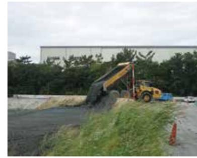
カルシア改質土の打設には重ダンプも利用。ベルトコンベア下の貯泥槽に溜まった改質土を積み込み、打設地点まで運搬し、流し入れていった。そこでもダンプアップによる落差2mの落下が生じるため、混合効果はさらに高まることになる
