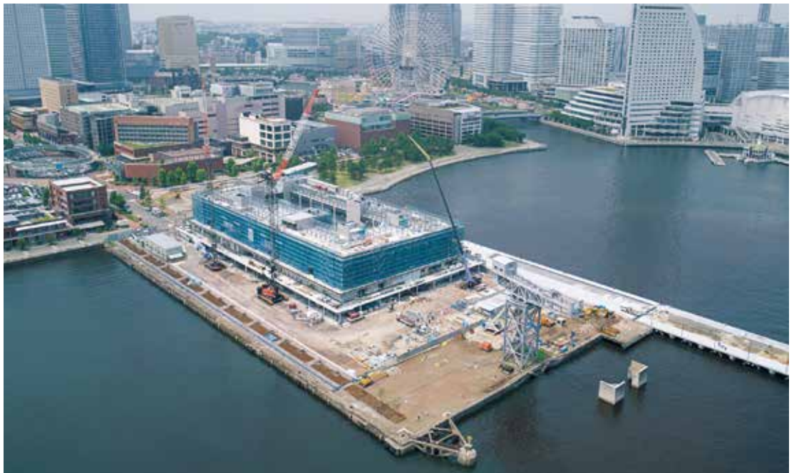
三方を海に囲まれた現場は工法や工区を工夫することで効率的に工事が進められた
