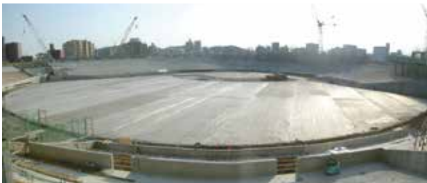
夏芝を植え付けた後、養生シートで覆ったところ
