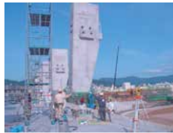
PCaPC造の柱を建て込む作業では精度管理が欠かせない。トランシットで柱脚部の基準と柱頭部のポイントを測定する。柱の側面に見える出っ張り部分が、PC圧着関節工法で用いる「コーベル」
