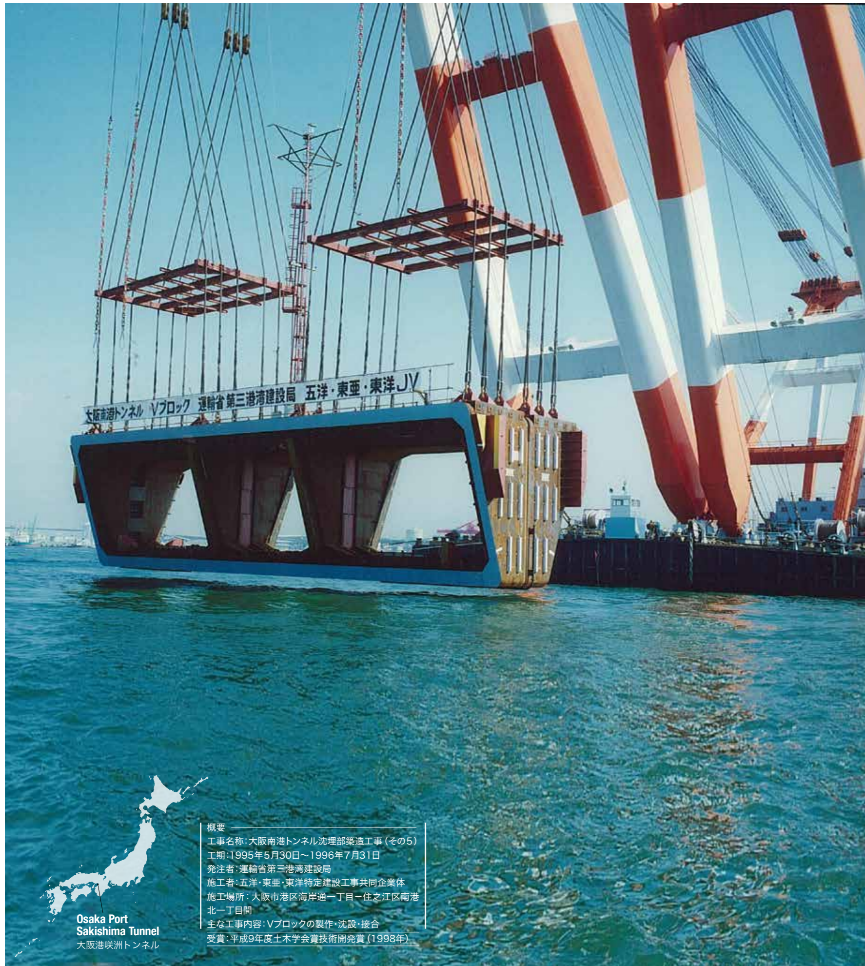
Vブロック沈設状況
