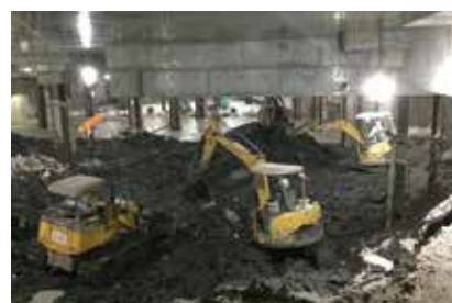
地下掘削状況 (床下部)
