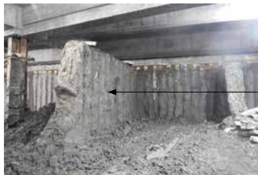
地中連続壁の変形を抑制するため、ソイルバットレスの施工を行った
