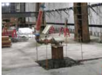
杭施工の完了後、ディープウェルによりSMW内の水位を低下させた
