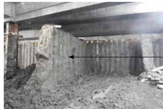
地中連続壁の変形を抑制するため、ソイルパットレスの施工を行った
