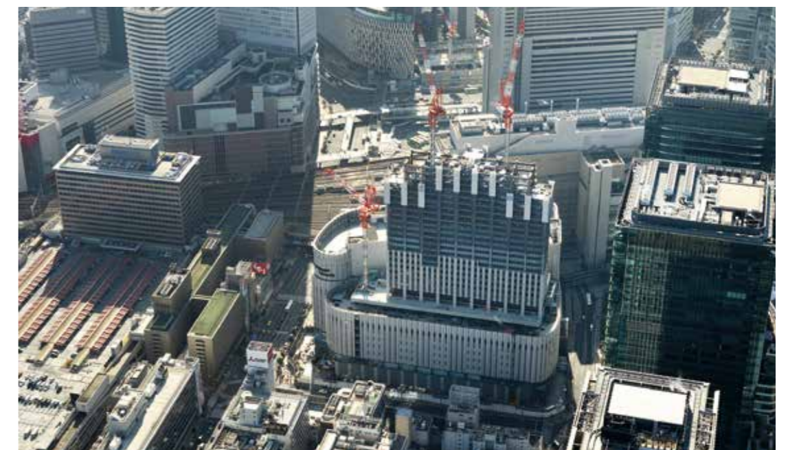
JR 大阪駅前の現場は、非常に交通量が多く高層建物やインフラが密集した地域（2019年1月撮影）
