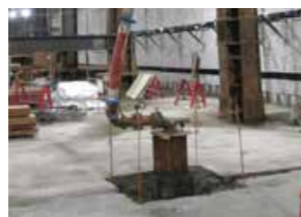
杭施工の完了後、ディープウェルによりSMW内の水位を低下させた
