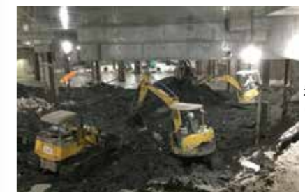
地下掘削状況 (床下部)
