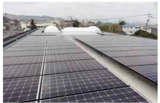
屋上の太陽光パネルは地上から見えないよう勾配を極力減らし、低床タイプの架台を採用して設置した
