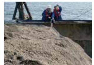
現場で断面を計測しデータ送信。各工区事務所でデータ処理と検収土量を登録
