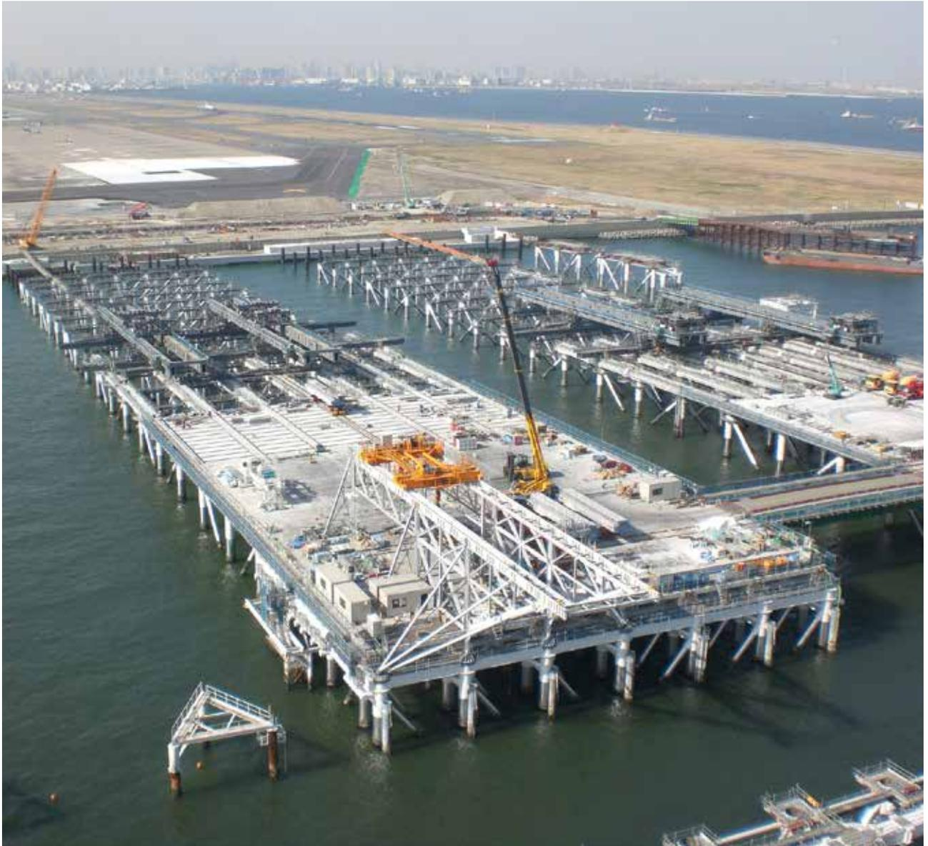
D滑走路は埋立部と多摩川河口部の通水性を確保するための栈橋構造部から構成される日本初のハイブリッド構造となった
