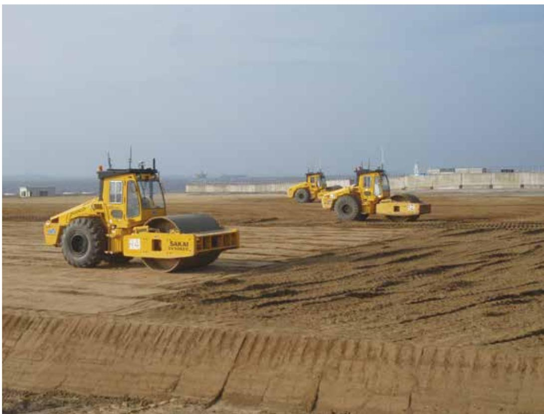
100年先までの供用が求められたD滑走路の埋立工事では、GPSのデータを用いる新しい工法にも取り組んだ
