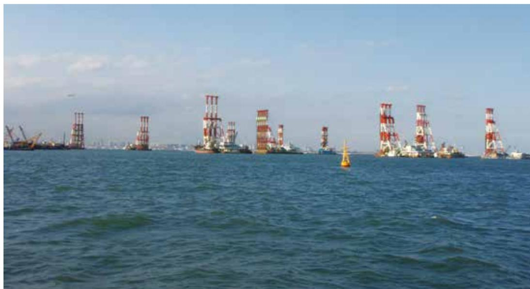
日本各地から作業船が一堂に会し、サンドコンパクションパイプ工法やサンドドレーン工法などの地盤改良を施工した
