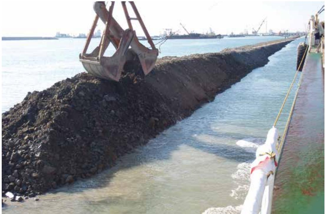
埋立の施工現場。掘削した海底の浚渫土を埋立材料に転用する、「管中混合固化処理工法」で納期と費用を抑えた
