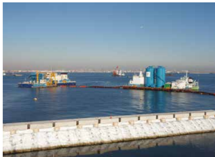
空気圧送で送られてきた処理土を、打設船で埋立地に打ち込む
