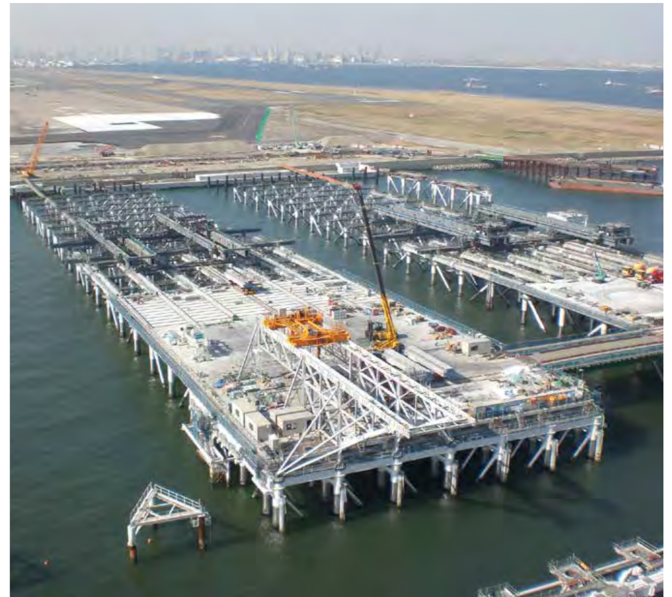
D滑走路は埋立部と多摩川河口部の通水性を確保するための桟橋構造部から構成される日本初のハイブリッド構造となった
