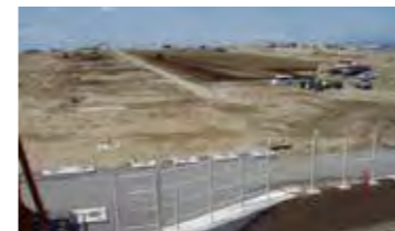
揚土2工の仕上げ中
