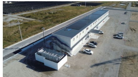
ZEB認証を取得した 工事事務所
