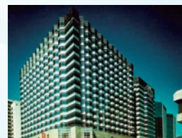
サンプラザビル受注 香港へ進出(1986)
