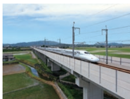
九州新幹線玉名津留高架橋完成(2008)
