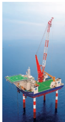
SEP型多目的起重機船「CP- 8001」完成(2018)
