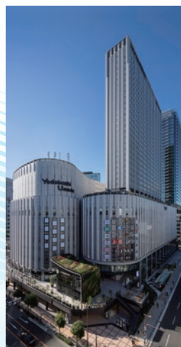
ヨドバシ梅田タワー竣工(2019)
