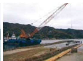
汚濁拡散防止対策の施工状況
