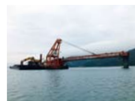
干潟造成の様子 船の先端には飛散防止装置を設置
