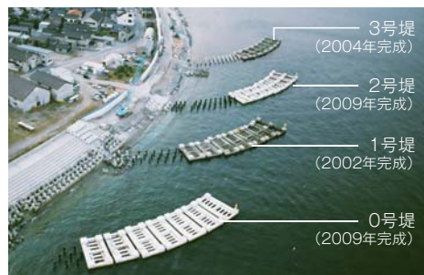
VHS工法にて完成した突堤
