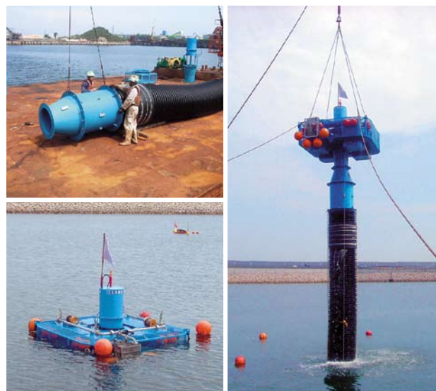
設置状況（設置場所の水深は約15m）
