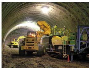
坑内ズリ搬出状況
