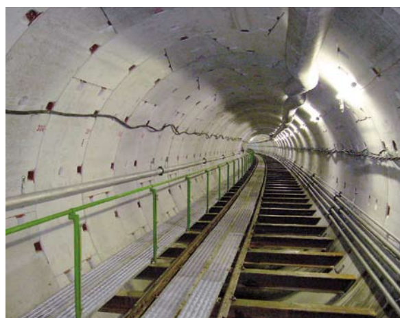
岡山西2工区共同溝第4工事／岡山県
