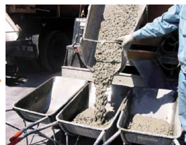
再生骨材コンクリート
