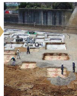
再生砕石場内利用
