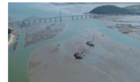
「山口港干潟再生(受託)工事第1工区」
