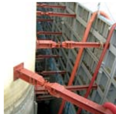
函体内部はドライにして補強します
