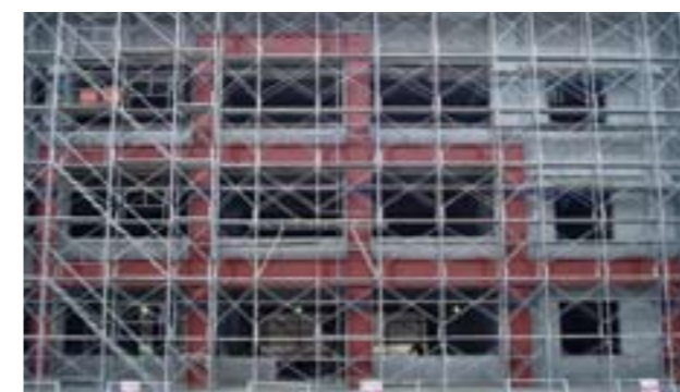
③学校での工事の様子
