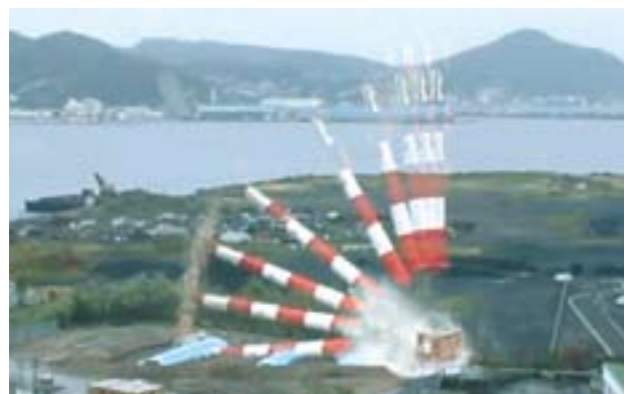
倒壊式発破解体工法による煙突倒壊までの様子
