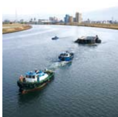
工場製作された函体を河川にて曳航します
