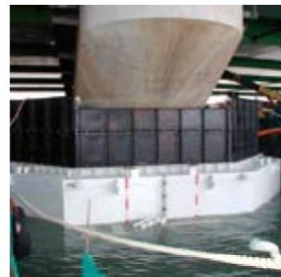
桁下空間が狭くても施工可能です
