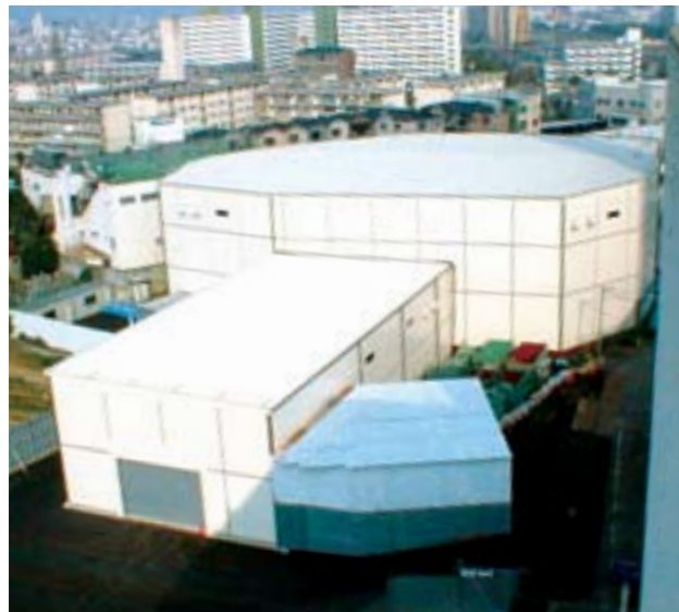
防塵建屋全景
