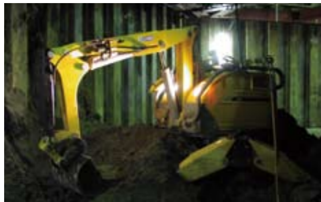
無人化施工状況
