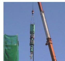
●煙突除染ロボット「ペンタクロス」2号機
