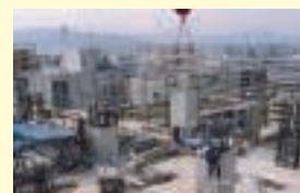
柱部材を設置
