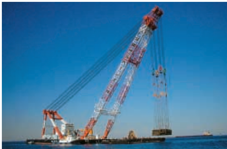
国内最大級（3,000t吊）の起重機船を使用した撤去作業
