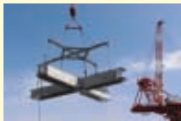
梁部材を設置
