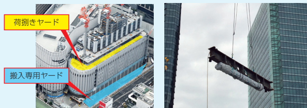
途中階の荷別きヤード
