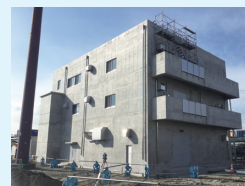
電気室棟建築工事
