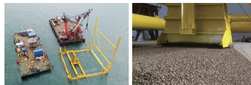
グラベルスプレッダーの設置状況(左)と試験施工の状況(右)
