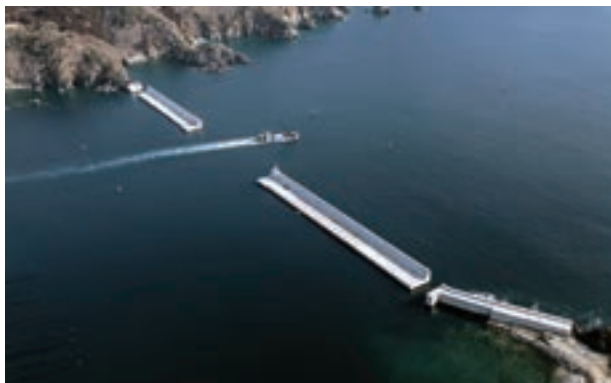
完成した大船渡港の湾口防波堤
