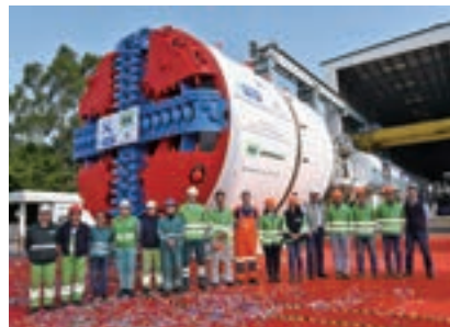
T219工区 トンネルボーリングマシン
