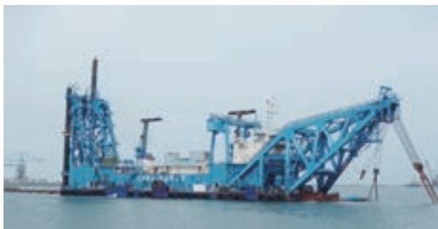
ポンプ浚渫船「第五スエズ」
