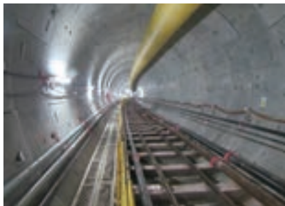
T202工区 施工状況
