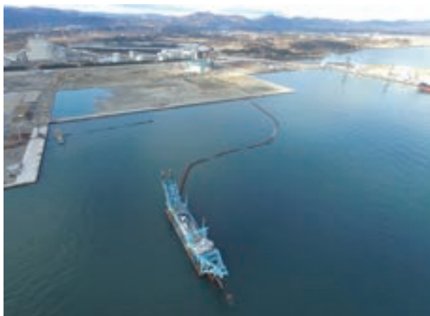
ポンプ浚渫船による浚渫・埋立
