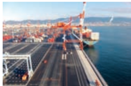
阪神港（神戸港：ポートアイランド地区）
