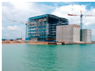
製作が続く大型ケーソン
