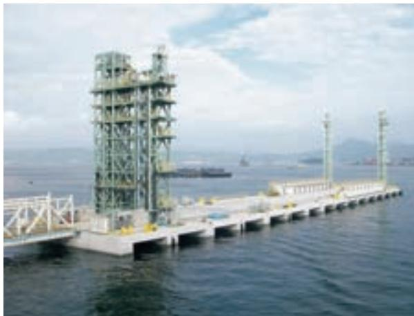
広島県呉港に延長150m、幅26mのIHIMU呉工場第2栈橋が当社の設計施工で完成しました。栈橋の上部に設置されている高さ30mの作業用エレベータータワーも当社の施工です。工期短縮とコスト削減のために、鋼管杭を海底地盤支持層まで打設した後、プレキャストコンクリート工法（あらかじめ工場などで製作されたコンクリート製品を設置する工法のこと）を採用し、栈橋を築造しました。この栈橋は新造船の艀装（船艀に必要な装備を取付けたりすること）が目的で、30万DWT（VLCC）クラスの超大型タンカーなどが使用します。
