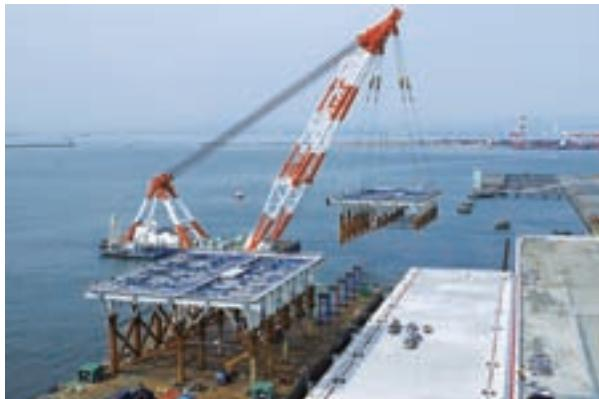
日本最大の貨物取扱量を誇る名古屋港において、スーパー中核港湾として国際競争力を向上させるため、大水深かつ地震にも強い次世代コンテナターミナルの整備が推進されています。その西部地区は一大物流拠点形成しており、コンテナ貨物を扱う飛島ふ頭の南側では、大水深（-16.0m）高規格のコンテナターミナルの整備が進められています。
