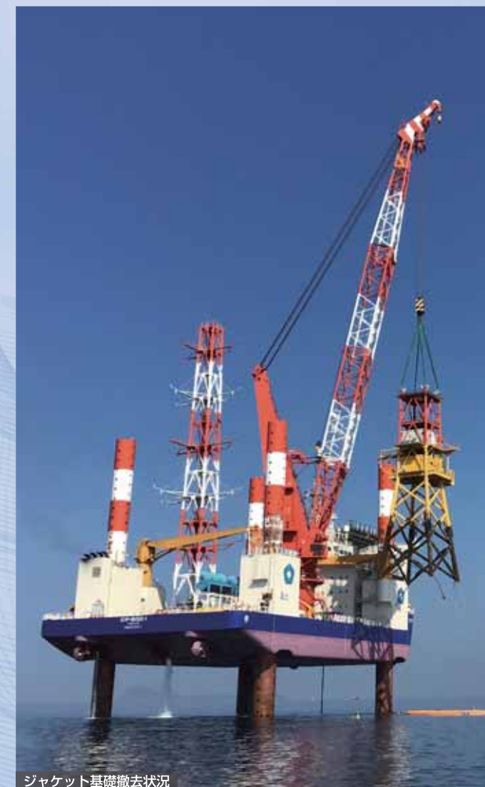
ジャケット基礎撤去状況
