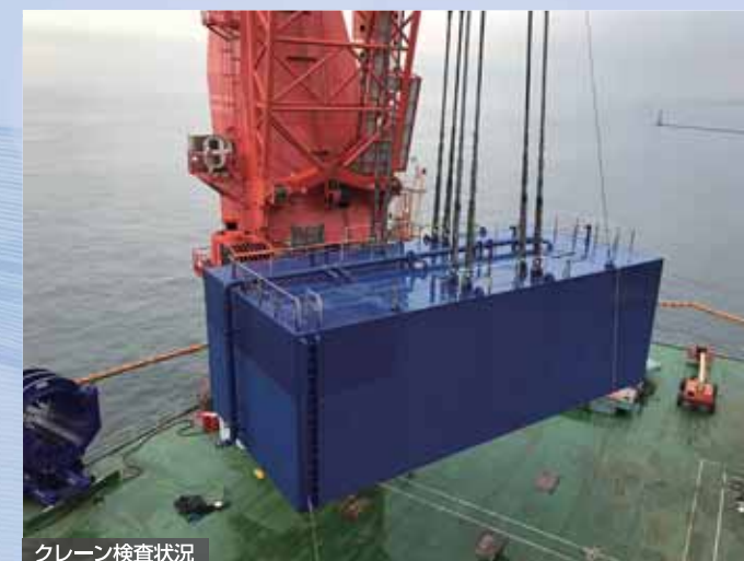
クレーン検査状況
