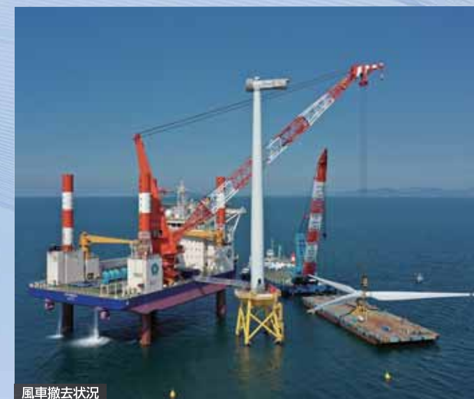
風車撤去状況
